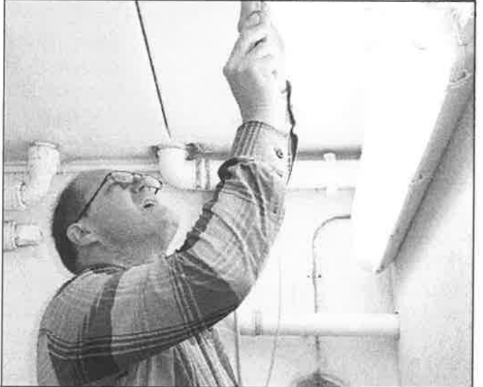
Le local des établis avance à grands pas : un bel éclairage blanc illumine les lieux. Jean-Michel et Etienne à la fixation du tubage réglementaire des câbles.
